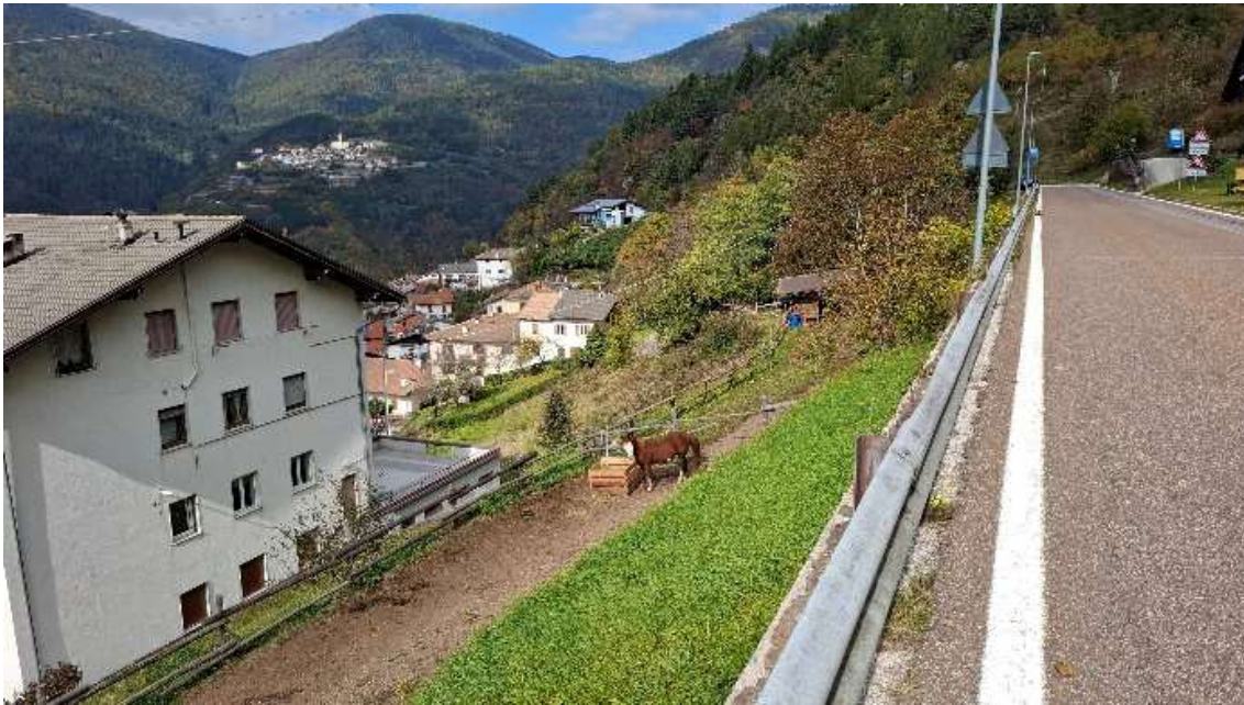
VISTA A VALLE DELLA STRADA VERSO NORD
