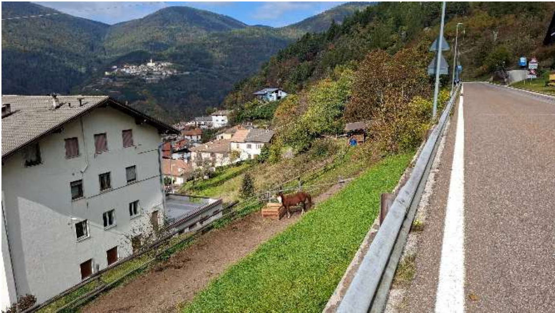
VISTA A VALLE DELLA STRADA VERSO NORD
